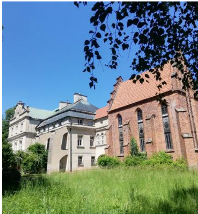
Pałac Chłapowskich od strony ogrodu z dobudowaną kaplicą.
